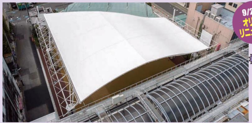
「屋根を大きく」の目的を達成するには、強度・費用・デザイン・使いやすさのバランスを取らなければならず、長い間検討を重ねた結果、トラス工法(三角形を基本とした構造)と屋根材にチタン膜を採用しました。
