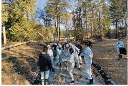
災害現場視察(下小池町)
